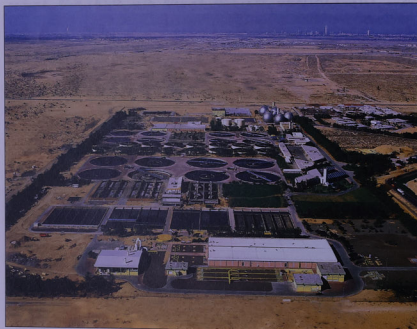
صورة جوية لمحطة معالجة مياه الصرف الصحي بالعين
