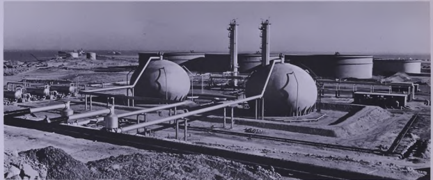
محطة عزل غاز بحقل زاكوم - De-gassing station for Zakum field
