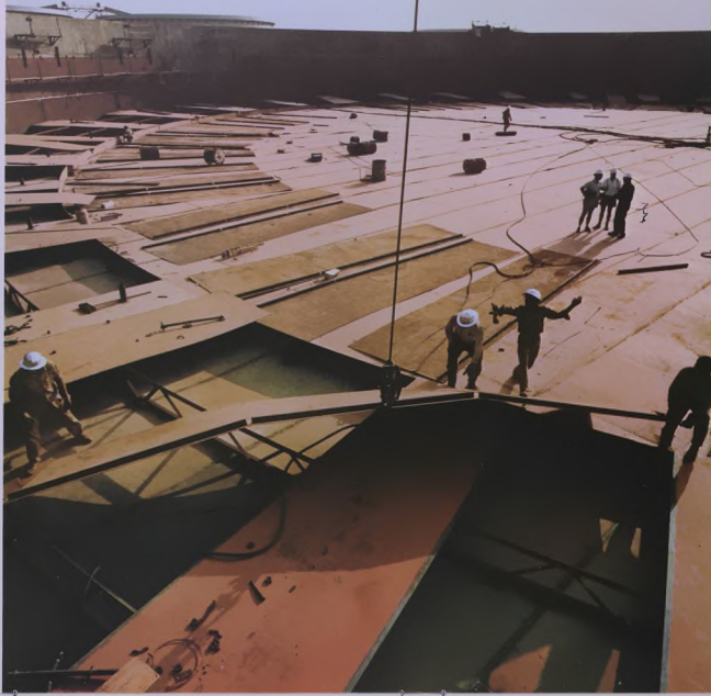
تشيد خزانات جديدة على جزيرة داس Erecting new storage tanks on Das Island
