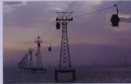
بواسطة السكة المعلقة المنقولة الخامات الأساسية من المرقا البحري لشركة الى مستودعات التخزين في المصهر The aerial ropeway transfers the raw materials from the Marine Terminal to silos for storage.
