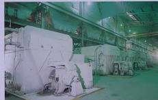
تقدم محطة الطاقة الكهربائية في البيا، ٢٤ توربينات تعمل بالغاز الطبيعي وتولد مجتمعة ٤٨٠ ميجاوات. في حين تستغل الحرارة المتبددة الصادرة عن خمس من هذه التوربينات لتشغيل توربين بخاري بقدرة ٦٠ ميجاوات.
