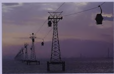
بواسطة السكة الحديدية المغلقة تنقل الخامات الأساسية من الرفق البحري للشركة إلى مستودعات التخزين في المصهر. The aerial ropeway transfers the raw materials from the Marine Terminal to silos for storage.
