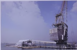
تقارء الأومينا والقطار والقار والقحم البترولي من السفن الى مرقا اليا البحري الواقع على بعد عشرة كيلومترات من المصهر. Alumina, pitch and petroleum coke are unloaded ten kilometres out to sea at the Marine Terminal.
