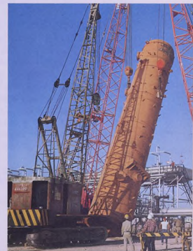
رفع أحد الأبراج الضخمة في معمل غاز البترول السائل في بقيق . A huge tower is hoisted at the Abqaiq LP Gas plant.
