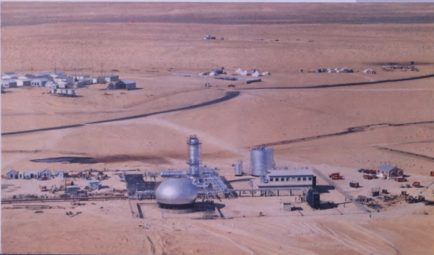
المعمل الموحدة للتكرير وفرز الغاز من الزيت في أبو حدادية ، وهو أول معمل من نوعه تقيمه الشركة. Aramco's first combined gas-oil separator plant and stabilizer is at Abu Hadriya.
