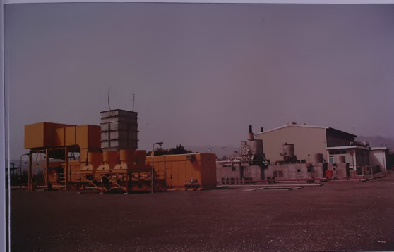
Kalba Power Station محطة توليد كهرباء كلباء
