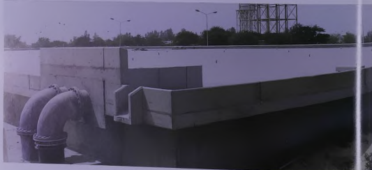
خزان الفلاج الأرضي لخلط مياه الأبار مع مياه التحلية في مدينة الشارقة Falaj Underground Tank for mixing desalinated and underground water
