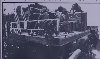
يجري العمل في مرمول على تركيب اجزاء جهاز الحفر الجديد
