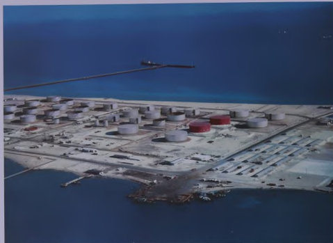
ساعد المقاولون العرب السعوديون على بناء سهاريج التكرير الجديدة (البينية باللون الاحمر) في فرشة راس نورث .
