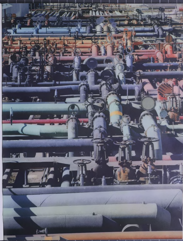
تستعمل الوان خاصة يكتن بواسطتها تمييز الانابيب الكثره بعضها من بعض في قرضة رأس تنورة النامية للشركة.
