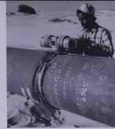
فني سعودي يفحص بأشعة رونتجن أحد الأجزاء المكونة في خط النايب السعابية الجديد .
