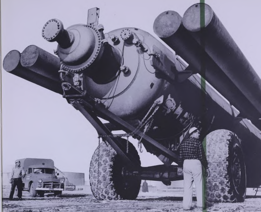
لنساند الاطارات الجبارة التي يبلغ نظر الواحد منها ١٠ اقدام على نقل مواد وحدة التعامل البالغ وزنه ١٨٢ طناً الى وحدة زرع المواد الكبريتية في معمل التكرير •
