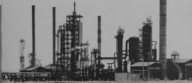
من بین أكثر الوحدات تعقيداً فی معمل التكرير فی راس تاوره وحدة اعادة تكوير السوائل (فی الوسط) •
