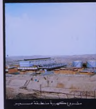
مشروع استكشاف بة منطقة مسيسبور
