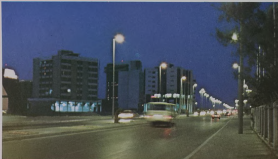
تقوم إدارة الكهرباء بإدارة مشاريع تطوير القطاع
