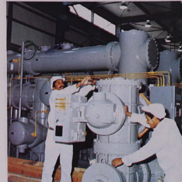
أحد أنواع الفانج الكهربائية تعمل بجزء ٦٦٠٠ فولت صنع في SP6 هذه سلكة نقل الطاقة الكهربائية
