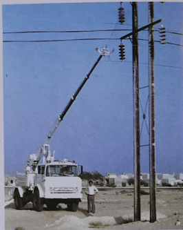
عملية عمل العارضة الكهربائية
