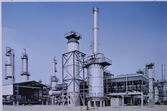
٢٥٦١٧٠ برميل / اليوم : وحدة معالجة النافثا بالهيدروجين (من البينين الى اليسار) الفرن ، مفاعل ، كاس هيدروجين ، الشنت وبرج فصل الهكسان .
