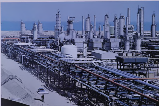
وحدة انتاج البتروجيلين : وحدة توليد البخار ، وحدات المعالجة بالهيدروجين ، وحدة غاز الرافان ، وحدة تجزئة النافثا ، وحدة الامين .
