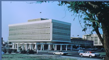
بنك الكويت الوطني الكويتي - مبنى المركز الرئيسي بالكويت
