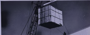
اerial مجموعة المصنع الكهربائية الجديدة من خلال سقف محطة الكهرباء
