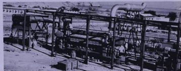
عملية تركيب المولدات الكهربائية وقد شارفت على الانتهاء
