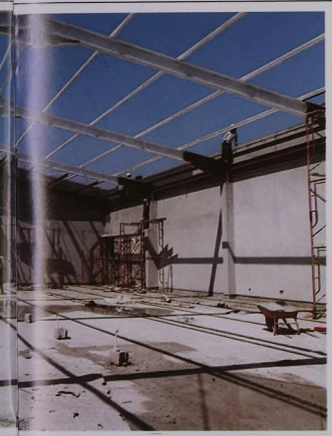
■ مشروع مبنى جمعية المحرق الإستهلاكية ...
