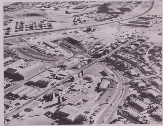
الطريق المؤسدة التي تبدو في مقدمة الصورة هي جزء من شارع الملك وتؤدي الى مبنى ادارة الشركة في الظهران .
