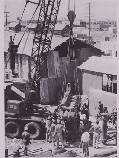
في سبيل تلبية الطلب المتزايد على القوة الكهربائية يزيد معمل كهرباء الخبر طاقته بتركيب مولد اضافي وزنه ١٤ طناً .
