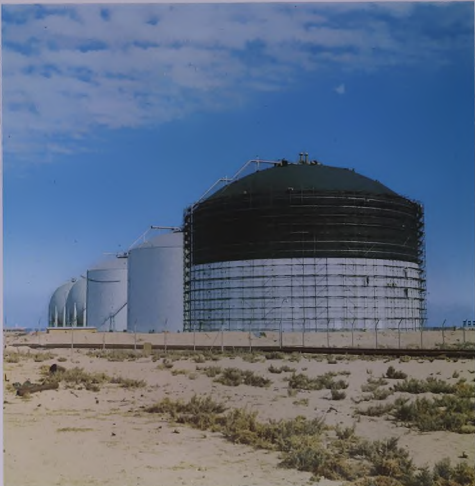
صهاريج خزن غاز البترول السائل في ميناء الاحمدي ، ويظهر في الصورة صهرج غاز البترول السائل المبرد الجفيدة أثناء الشحنه .
