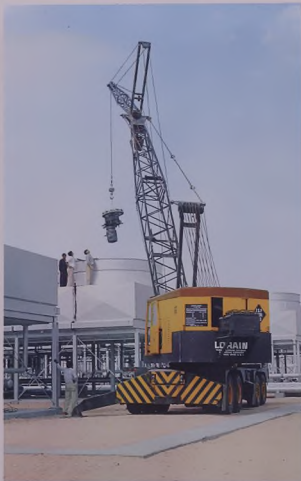
مرغ بسلامة قطر طاقته ٢٧ طن أثناء استخدامه في الناقل A 27 ton spark-proof crane at work at Minagih
