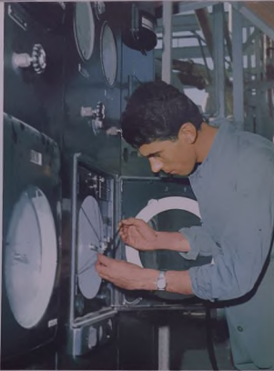
مخرب يربط بين ريشة المحصل A trainee links the pan of a compressor
