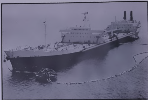
ناقلة بترول أثناء التحميل من عوامة ارساء منفردة لشركة شل ( جزيرة حالول ) Tanker Loading at S. B. M. (Halul Island) of Shell Co.
