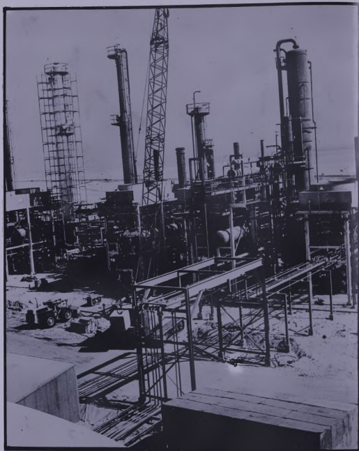
مشروع مصفاة البترول الجديد
