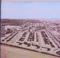
منطقة سكن العمال والسوق الجميع Employee housing and shopping area
