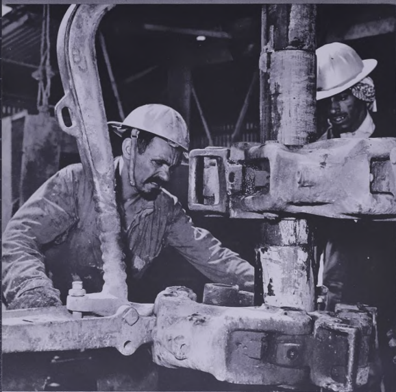
عاملان حفر كويتيان يستحيان التيوب الحفر Kuwaiti rigmen pulling drill pipe
