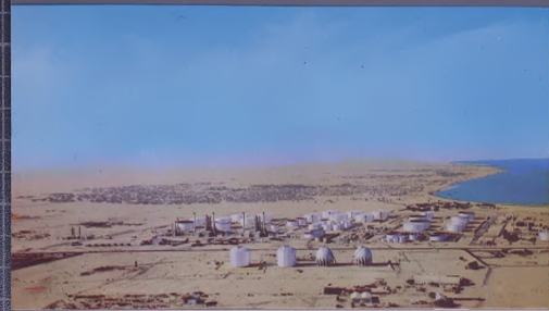
منطقة عمل التكرير ويظهر الصورج الجديد للغاز البترول السائل في يسار صدر الصورة Refinery area, showing new L.P.G. tank in left foreground
