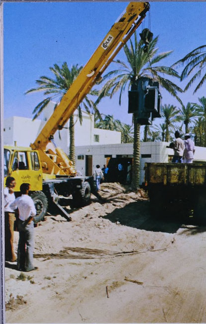
تركيب محول في احدى البنايات الجديدة
