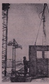
Шькылдә: бригадир Н. Мәшиңкә авәйә жийинә монтаж дькә. Фот'о йә А. Крәвк'иң.
