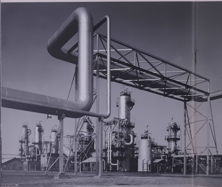
الغازات السامة تطرد من الزيت الخام في معمل التركيز ببقيق .
