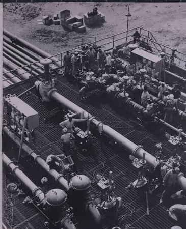
المازجة الجديدة تده حاجات السوق الخاصة بمرج مختلف الأنواع من الزيت الخام والمنتجات الكبرية .
