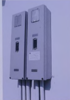
معدن خروج برمكة داخل عمدة Meter Installation and Bill Pocket
