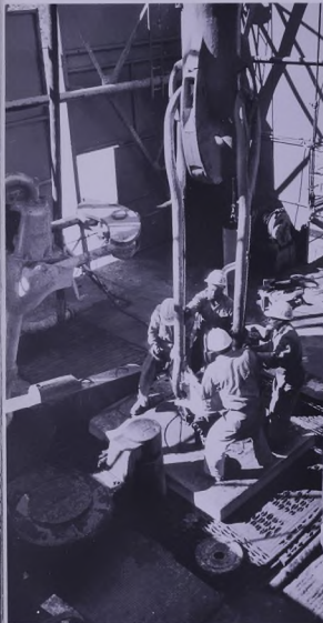
أعمال الحفر في حقل أبو حديفة .
