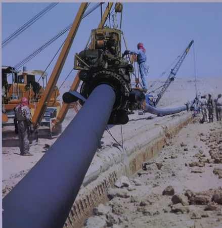
Coating and wrapping the new 77-mile transit line. عطاء ولف خط الانابيب الجديد وطوله ٧٧ ميلاً لنقل النفط.
