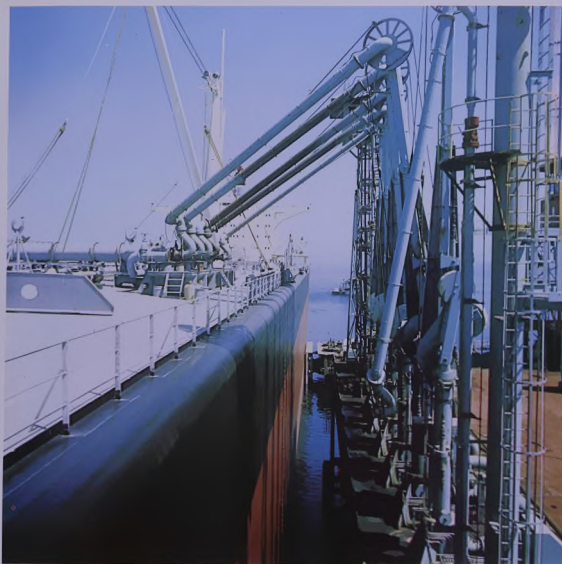
(اليمين) منظر جوي للجزيرة الاصطناعية (إعلاء) أدوم التحميل من طراز تشيكسان على الجزيرة الاصطناعية (Right) Aerial view of the Sea Island and (above) Chiksan loading units at the Sea Island.
