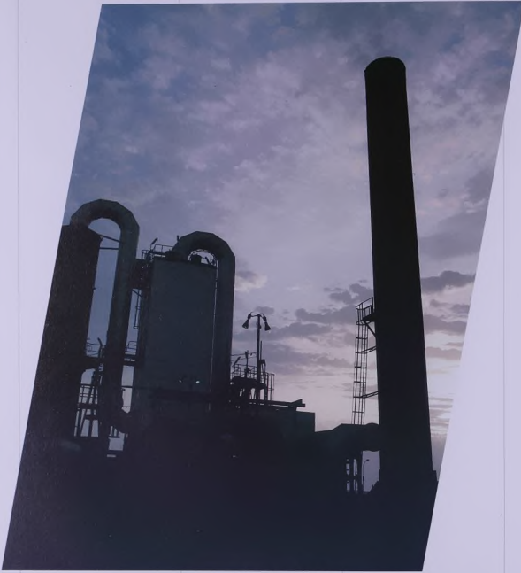
الذخان الصادر من أفران تجهيف الألومينا أصبح الآن انطفق بنسبة ٩,٨ في المئة إثر تركيب وتشغيل وحدة تنظيف الغازات
