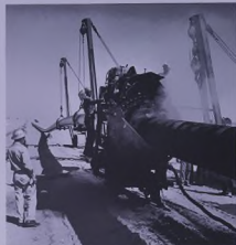
خط الأنابيب الجديد الذي ينقل الزيت من حقل الخرسانية يلف ويظن بالتفطيران فيسبب طمره لواقبته من التآكل .
