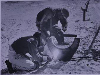
تُكتمل في الآبار الجديدة خلال شهر من عمل الآبار الجديدة الممتدة إلى القسم الجنوبي من الحقل. Steel supports are built in order to carry part of new pipeline to southern Ghawar field.
