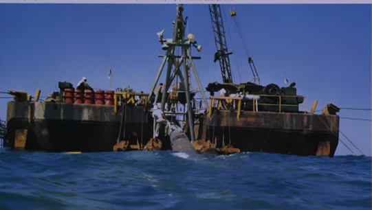
عمل في الآبار يستعمل في ما أصبح حقل لإزدياد الطاقة على حقل المشامية المتصور بأنه . A preflaring barge puts down underwater line to increase productive capacity of offshore Safaniya field.
