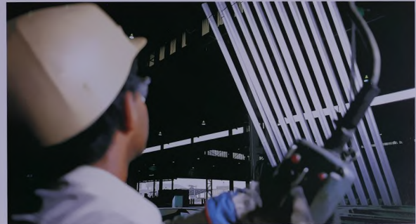
رفع مجموعة من قوالب السحب، من وحدة التبريد المباشر
