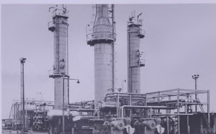
الى اليسار : مستأق الضغط المعدة لصنع الغاز السيل في احد مراكز التصنيع في الحقول الى اليمين : وحدات التبريد لصنع غاز البترول المسيل في معمل التكرير
