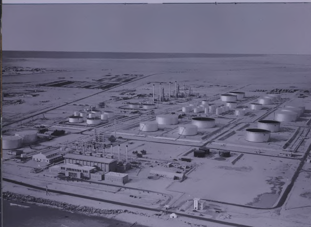
معمل تزيده الاحمدي ، ويتبو في الامام عجلة توليد الكهرباء الرئيسية ووحدة تقطير مياه البحر ، وفي الوسط برجا التقطير وقتلت كل منهما ٨٠٠٠٠٠ برميل يوميا ، ومثلت من سجلية سهاريج الحزن
