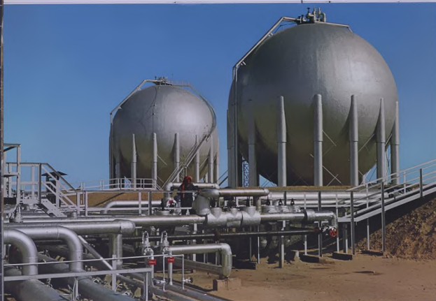
مستودع الغاز - كرتا هورتن - وسعة كل منهما ٦٥٠٠٠ برميل ويصممان لتخزين غاز البترول المسيل في ميناء الاحمدي
