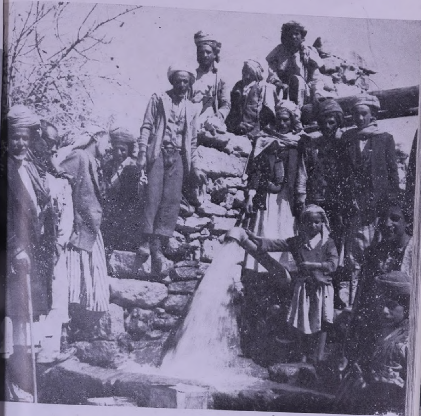
استخدام مضخات المياه في ري الأراضى الواسعة Water pumps used to irrigate large areas of land.
