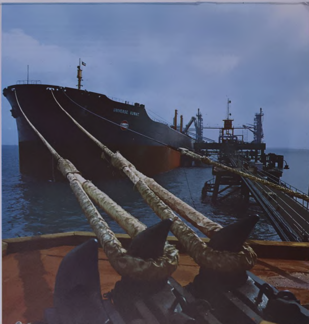
الناقله « يونيفيرس كويت » راسية إلى الجزيرة الاصطناعية . The "Universe Kuwait" at berth on the Sea Island.
