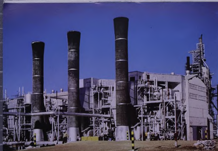
محطة القوى الكهربائية رقم « ٢ » حيث يظهر المرجل الجديد الذي طاقته ٢٠٠ ألف رطل في الساعة No. 2 Power Plant, showing the new 200,000 pounds-per-hour boiler.
